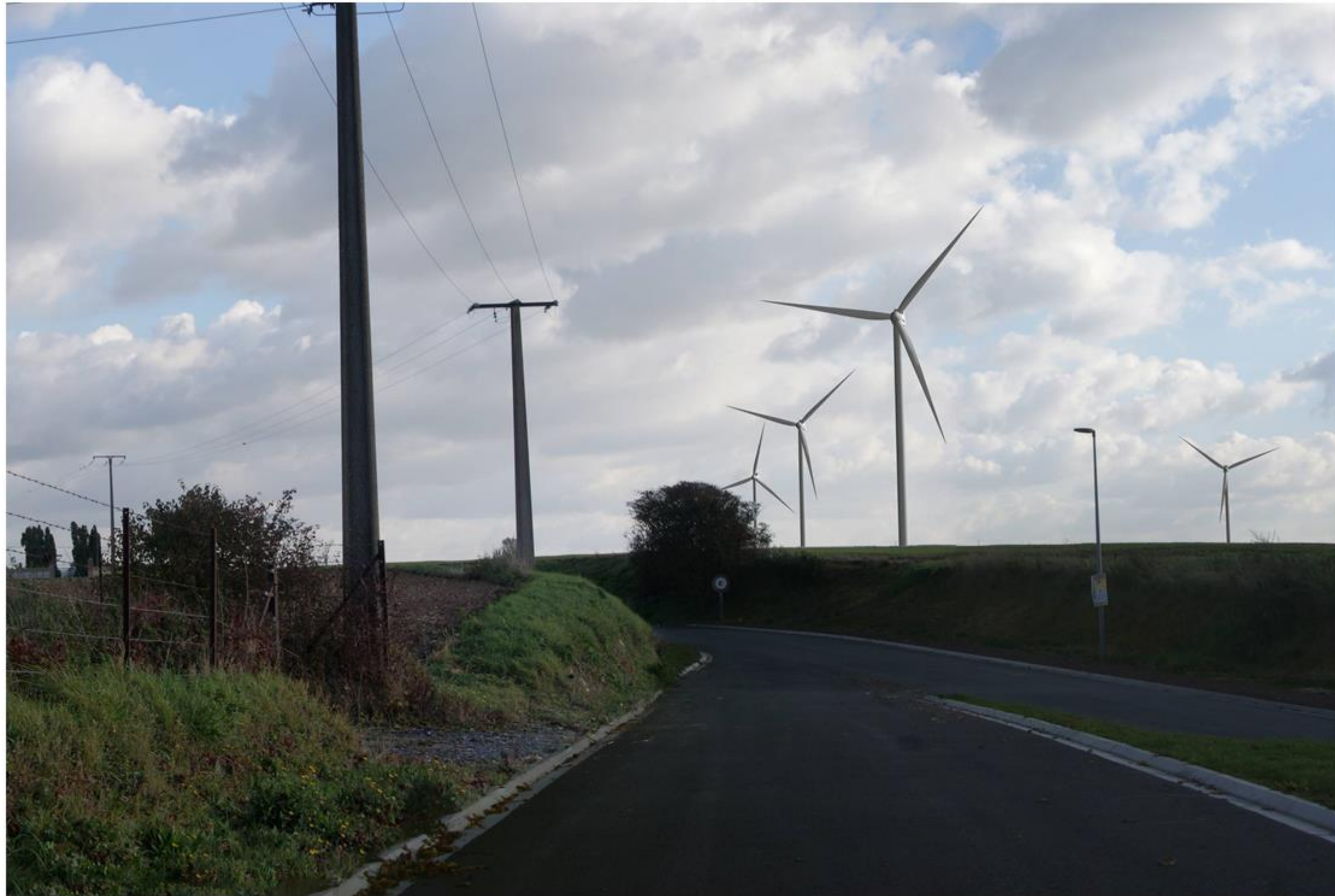
Vue réelle vers la partie Sud du projet
